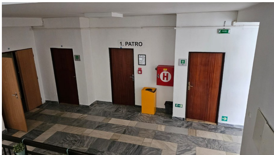
Obrázek 12 Požární hydrant a tlačítko
