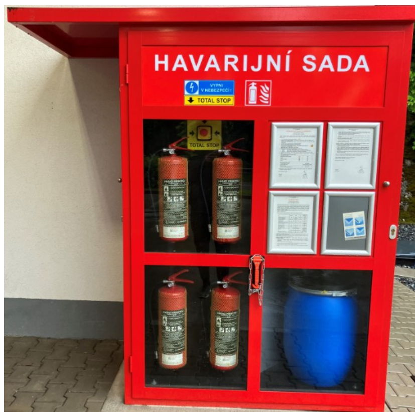
Obrázek 36 Ukázka provedení havarijního boxu
