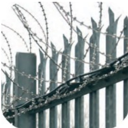
Obrázek 19 Uložení kabelu na plot
