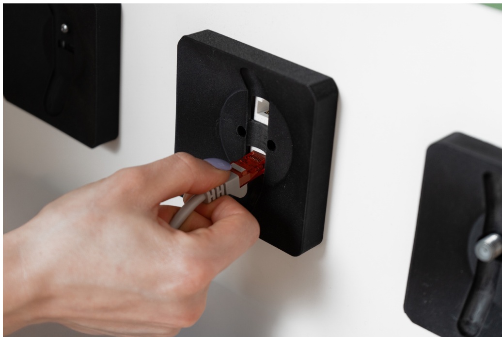
Obrázok 53 Ukážka zapojenia dátovej zásuvky
