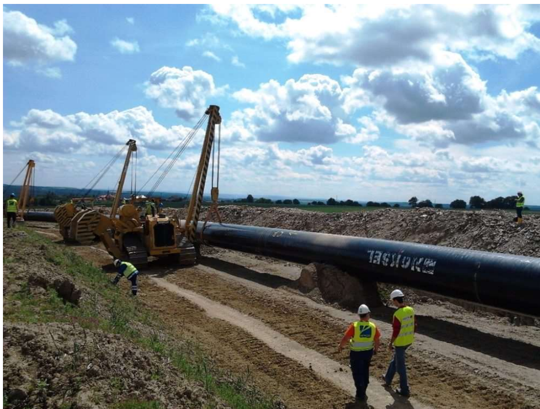
Obrázek 5. Výstavba plynovodu Gazela [16]
