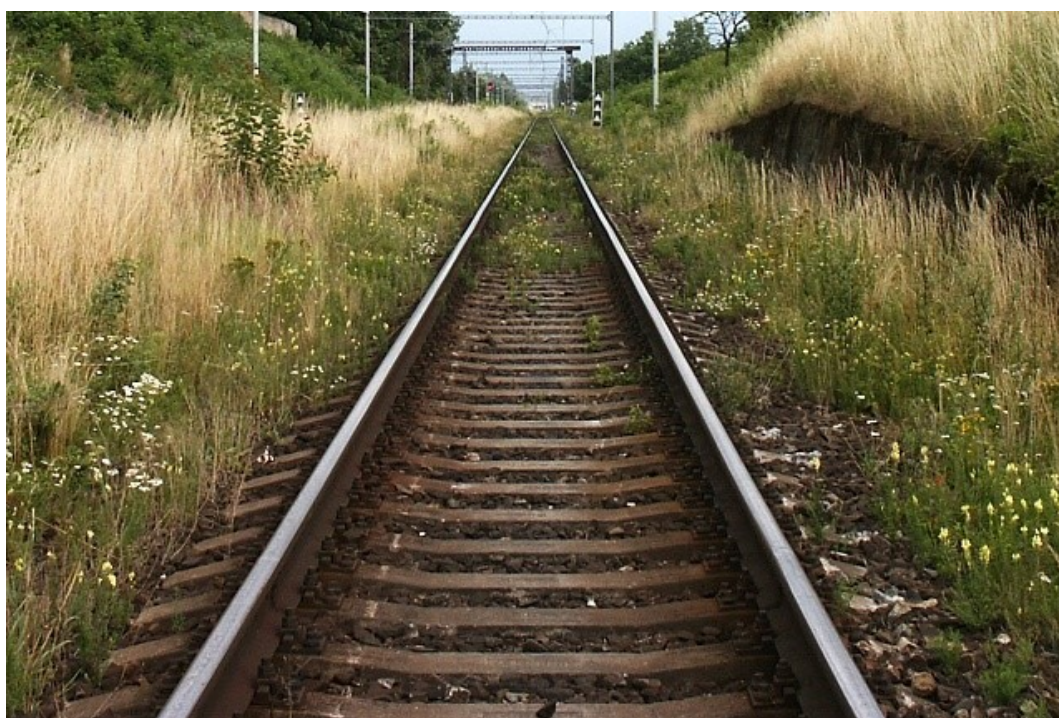
Obrázek 1 Sbíhající se kolejnice [4]
