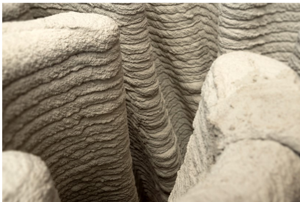
Obrázek 8 Zed' z 3D tiskárny [79]
