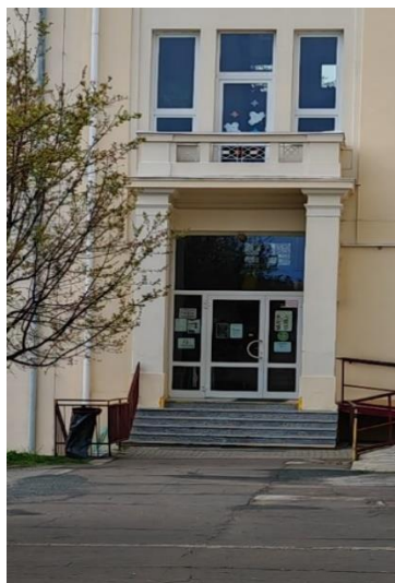
Obrázek 6 Hlavní vstup do budovy (zdroj: vlastní)
