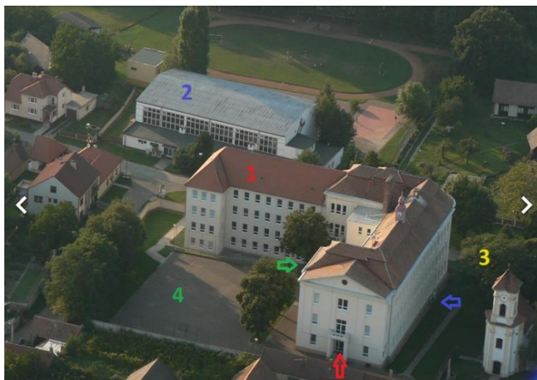
Obrázek 4 Letecký snímek budovy ZŠ (zdroj: ZŠ Strážnice)
