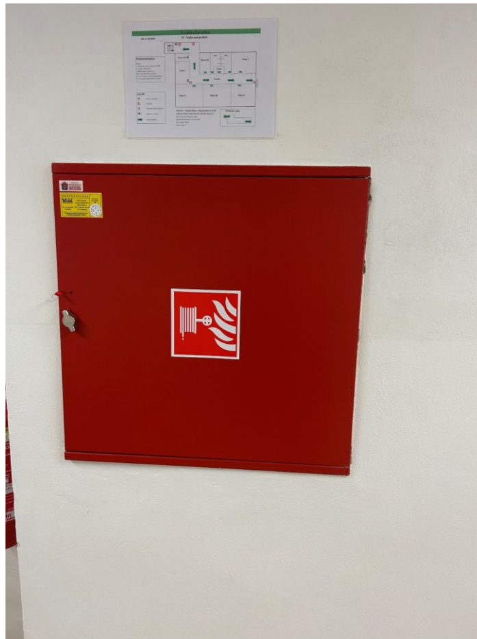
Obrázek 16 – Nástěnné hydranty (vlastní, 2024)
