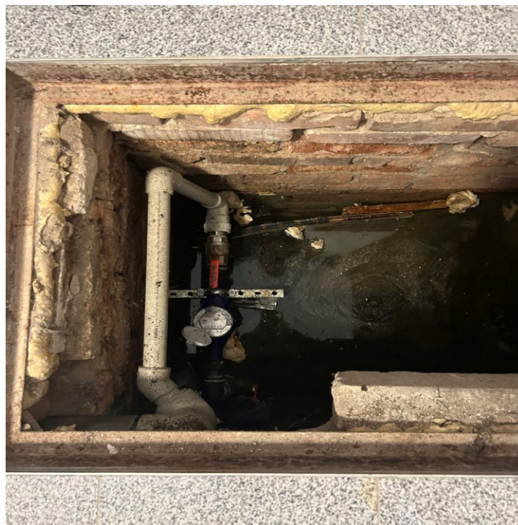
Obrázek 8 – hlavní uzávěr vody (vlastní, 2024)
