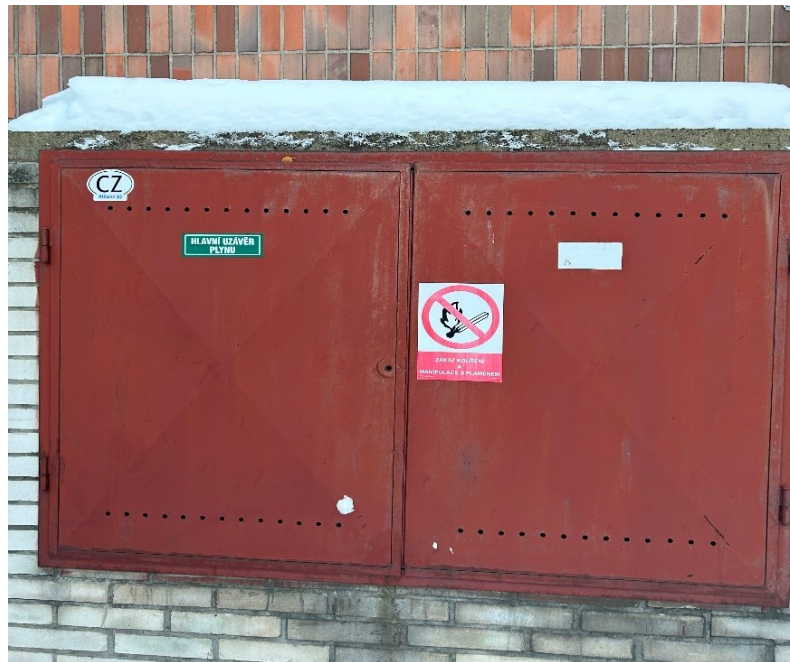
Obrázek 9 – hlavní uzávěr plynu (vlastní, 2024)
