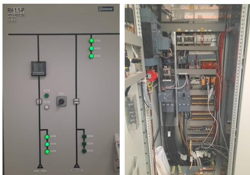
Obrázek 37 – Ukázka signalizace, ovládacích prvků (vlevo) a vnitřku (vpravo) RH1.1
