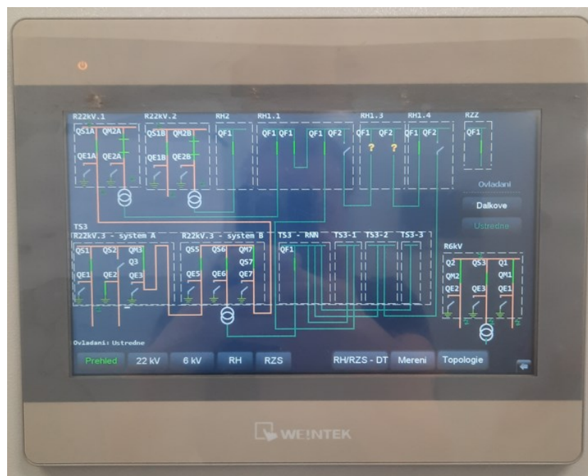
Obrázek 51 – Zobrazení přehledu na HMI panelu Weintek
