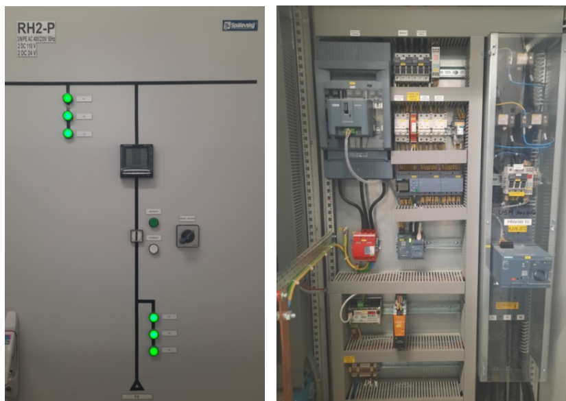
Obrázek 30 - Ukázka signalizace, ovládacích prvků (vlevo) a vnitřku (vpravo) RH2
