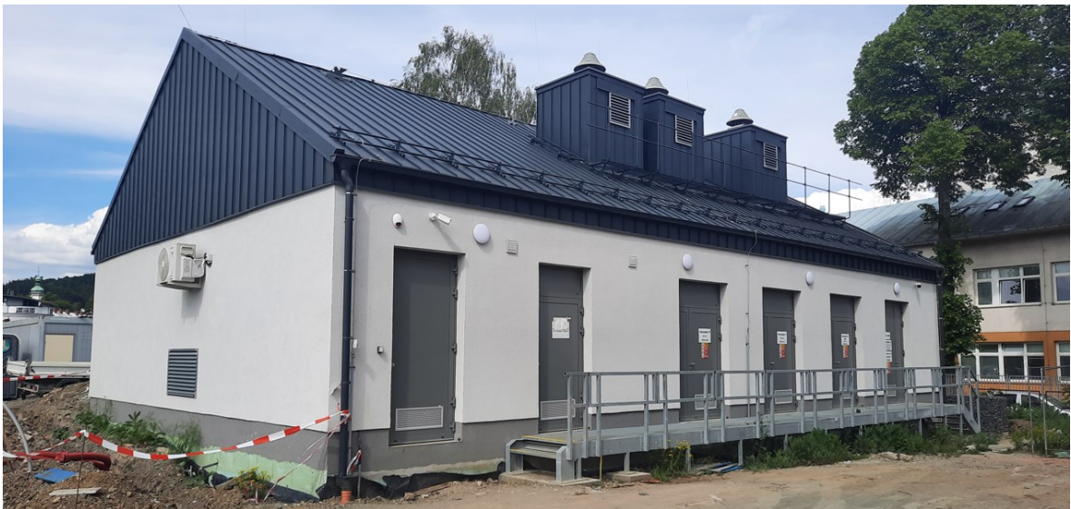
Obrázek 17 – Budova technologického objektu
