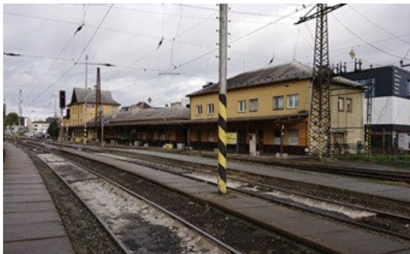
Obrázek 12 – Původní výpravní budova a kolejiště [19]
