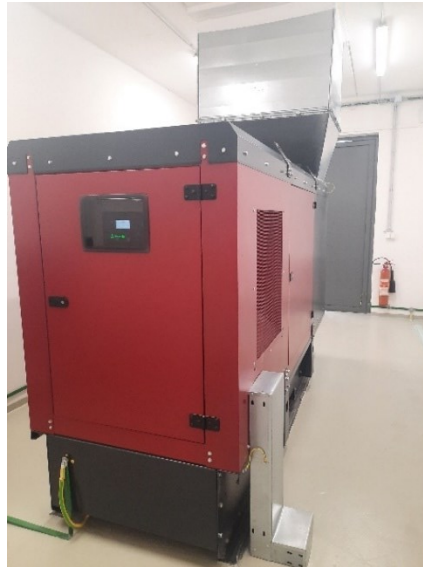
Obrázek 35 – Ovládaný diesel agregát
