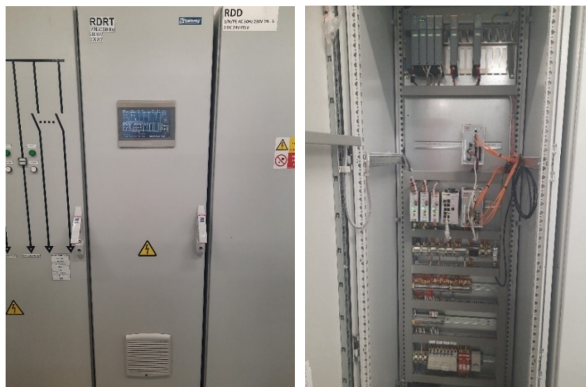
Obrázek 42 – Ukázka HMI (vlevo) a vnitřku (vpravo) RDRT
