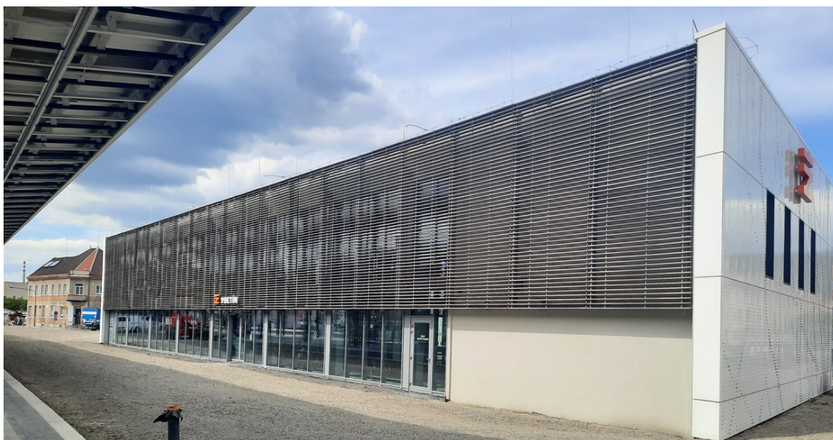
Obrázek 13 – Budova dopravního terminálu
