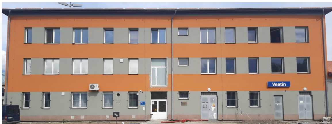
Obrázek 15 – Budova rozvodny zabezpečovacích zařízení
