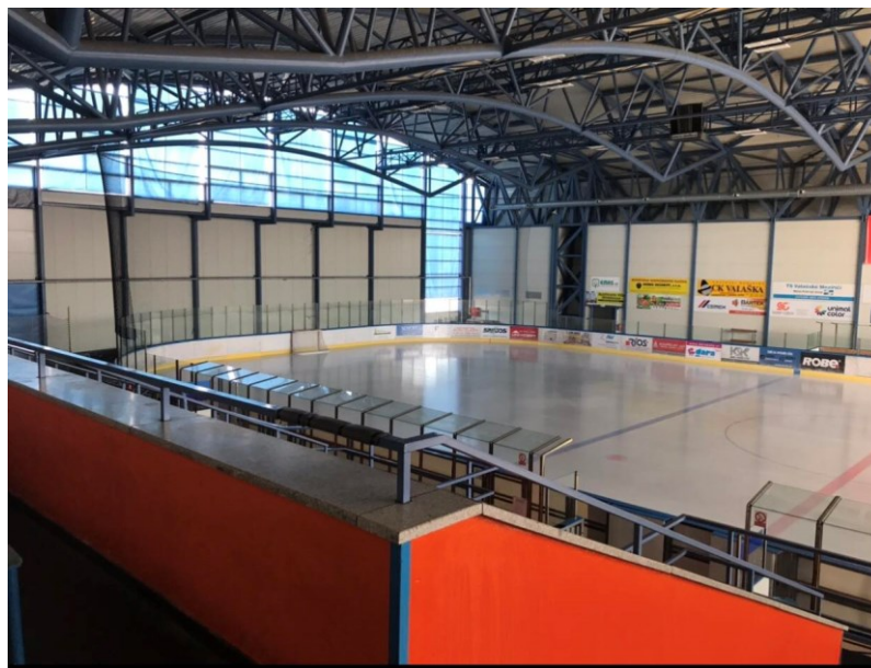
Obrázek 7 Fotografie zimního stadionu ve Valašském Meziříčí zevnitř I. část
