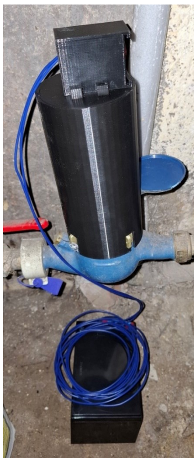
Obrázek 35. Umístění kamery na vodoměru
