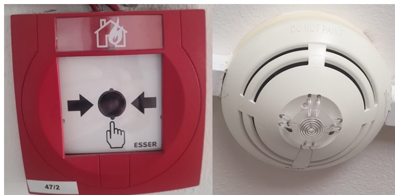
Obrázek 4 Hlásiče požáru [vlastní]
