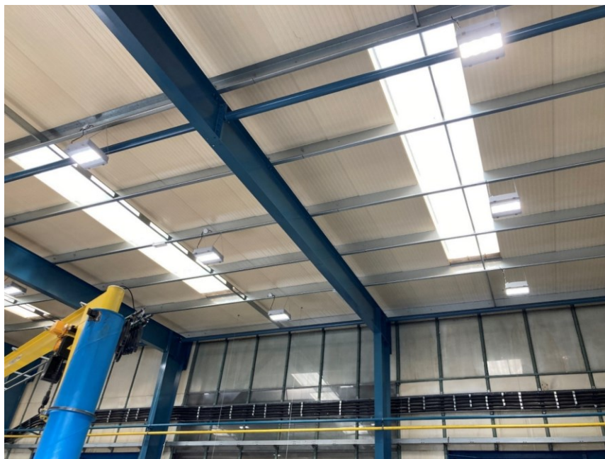
Obrázek 6 Střešní okna haly (vlastní)
