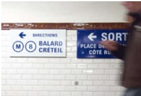
Obr. 23. Přestupní chodba s prvky původního informačního systému
