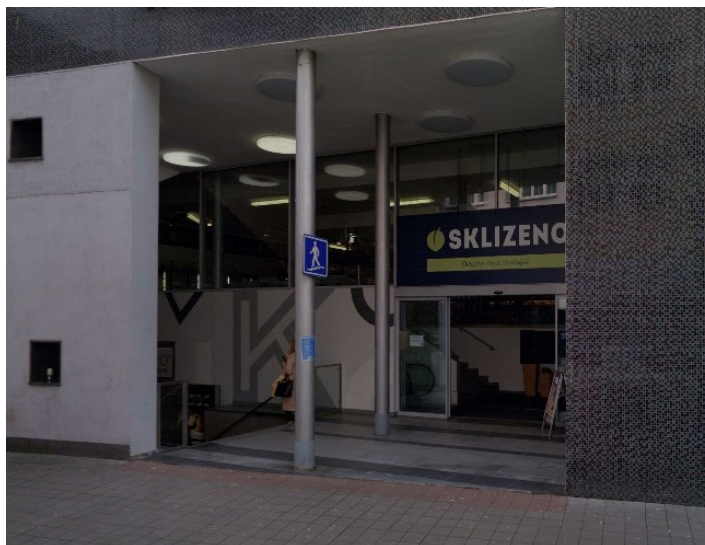
Obr. 9. Vstup č. 3 vedoucí do podchodu a OC [14]
