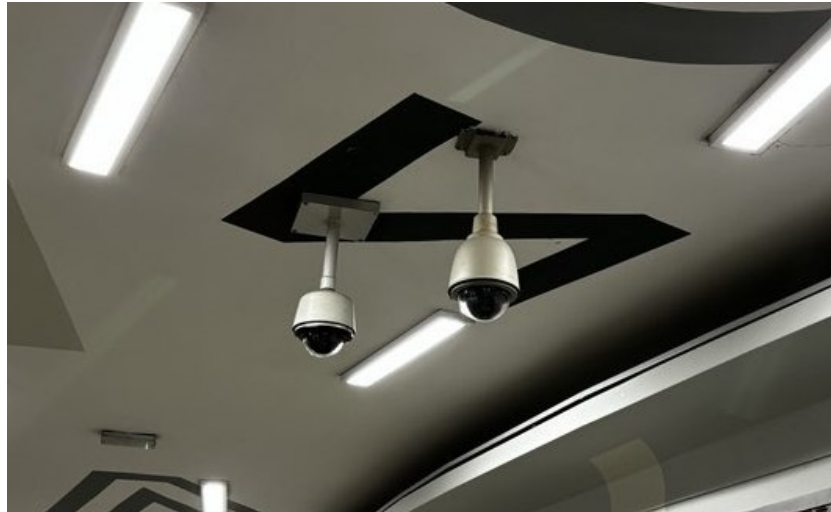
Obr. 14. Kamerový systém v podchodu [vlastní]
