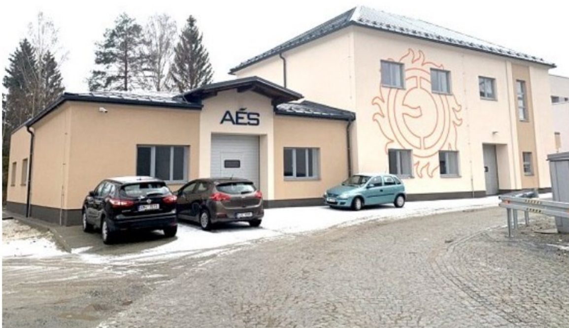
Obrázek 14 Budova AES (Sériová výroba domovních akumulčních stanic v Jeseníku, 2020)
