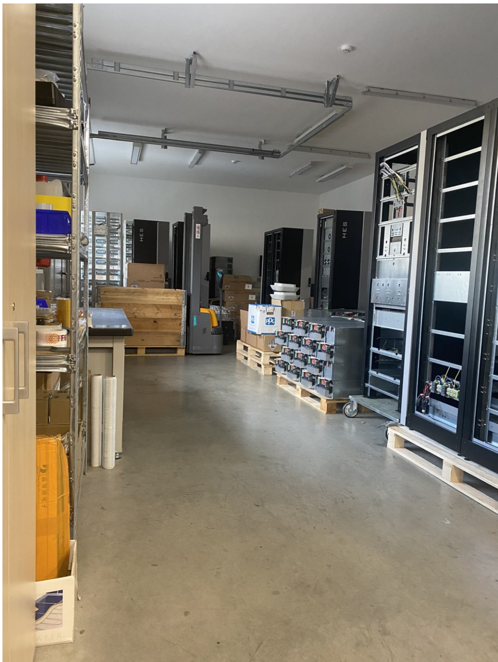
Obrázek 16 Současný stav skladového prostoru (zdroj vlastní)
