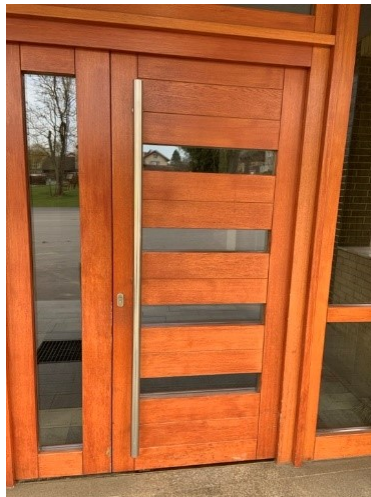
Obrázek 15 – Vstupní dveře do víceúčelového společenského domu
