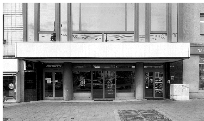
Obrázek 15: Vstupní část do budovy (Vlastní zdroj)
