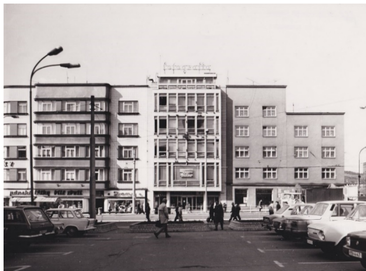
Obrázek 14: Celkový pohled na fasádu budovy (Horňáková, 20.stol.n. l.)
