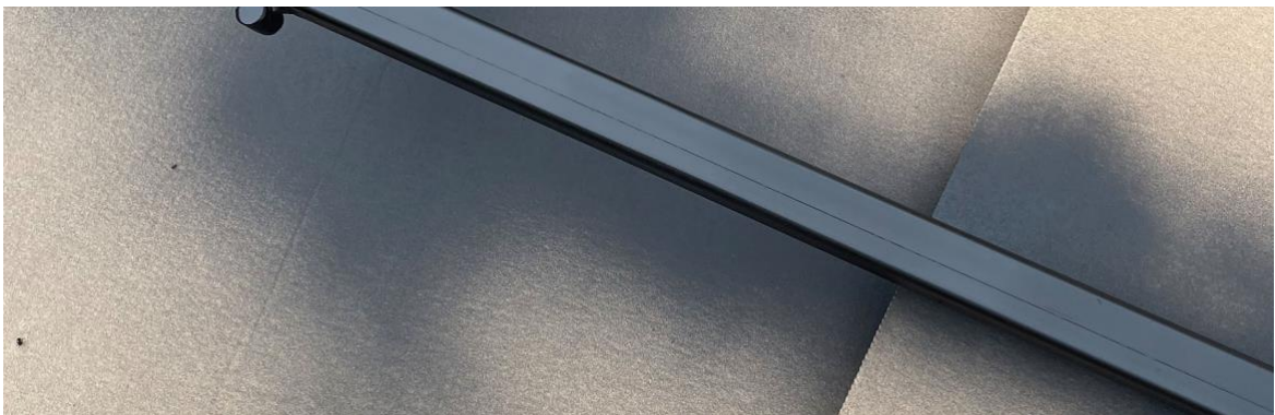
Obrázok 42 Povrchová úprava akrylovým lakom
