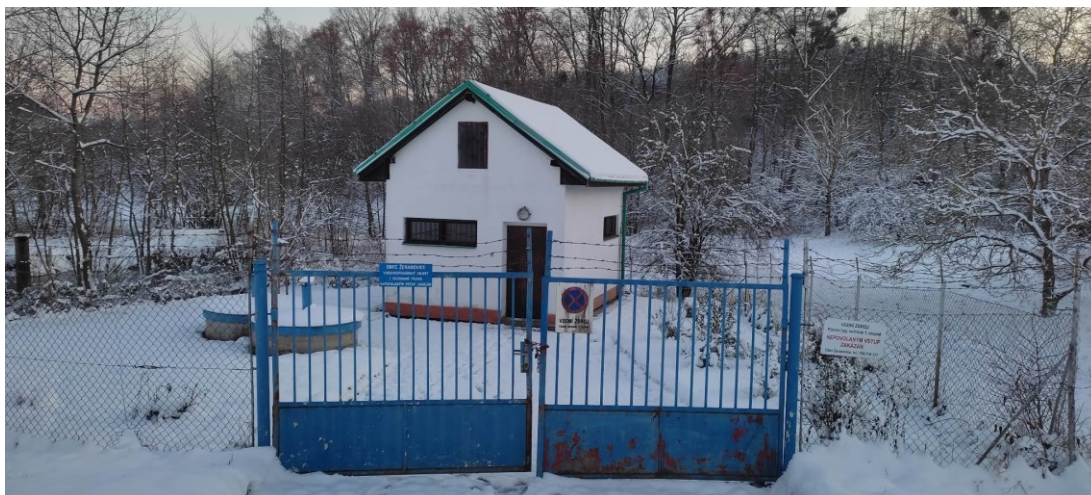
Obrázek 10 Přečerpávací stanice č. 1 [vlastní]
