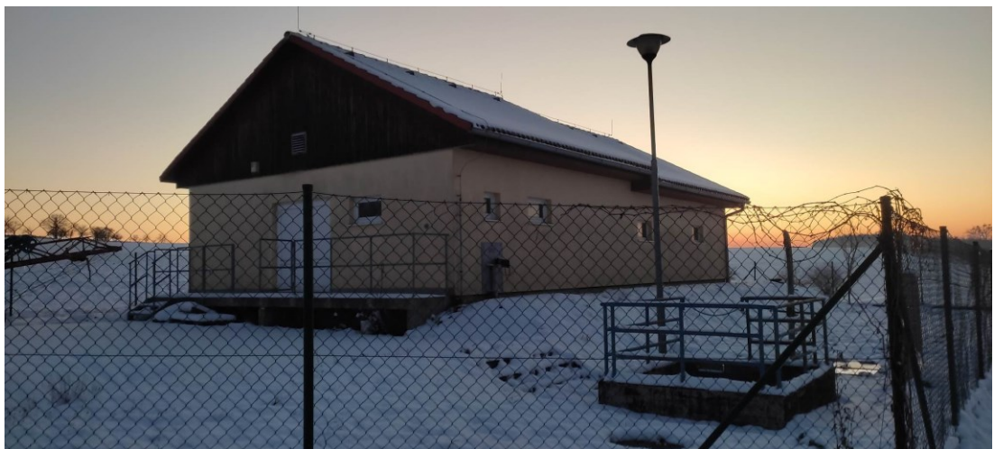
Obrázek 12 Čistička odpadních vod [vlastní]
