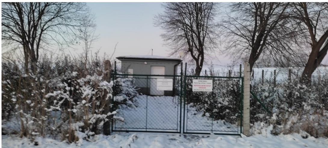
Obrázek 11 Přečerpávací stanice č. 2 [vlastní]
