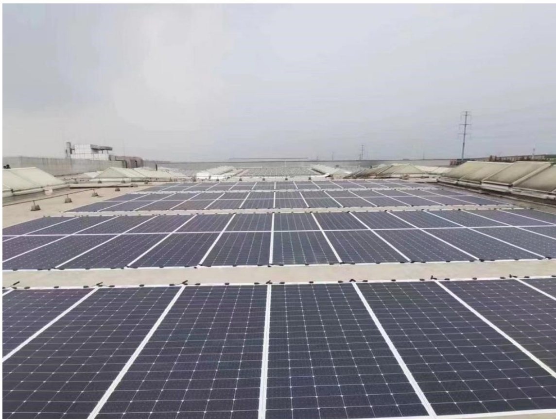
Obrázek 29 Instalace flexibilních panelů (Zdroj: vlastní)
