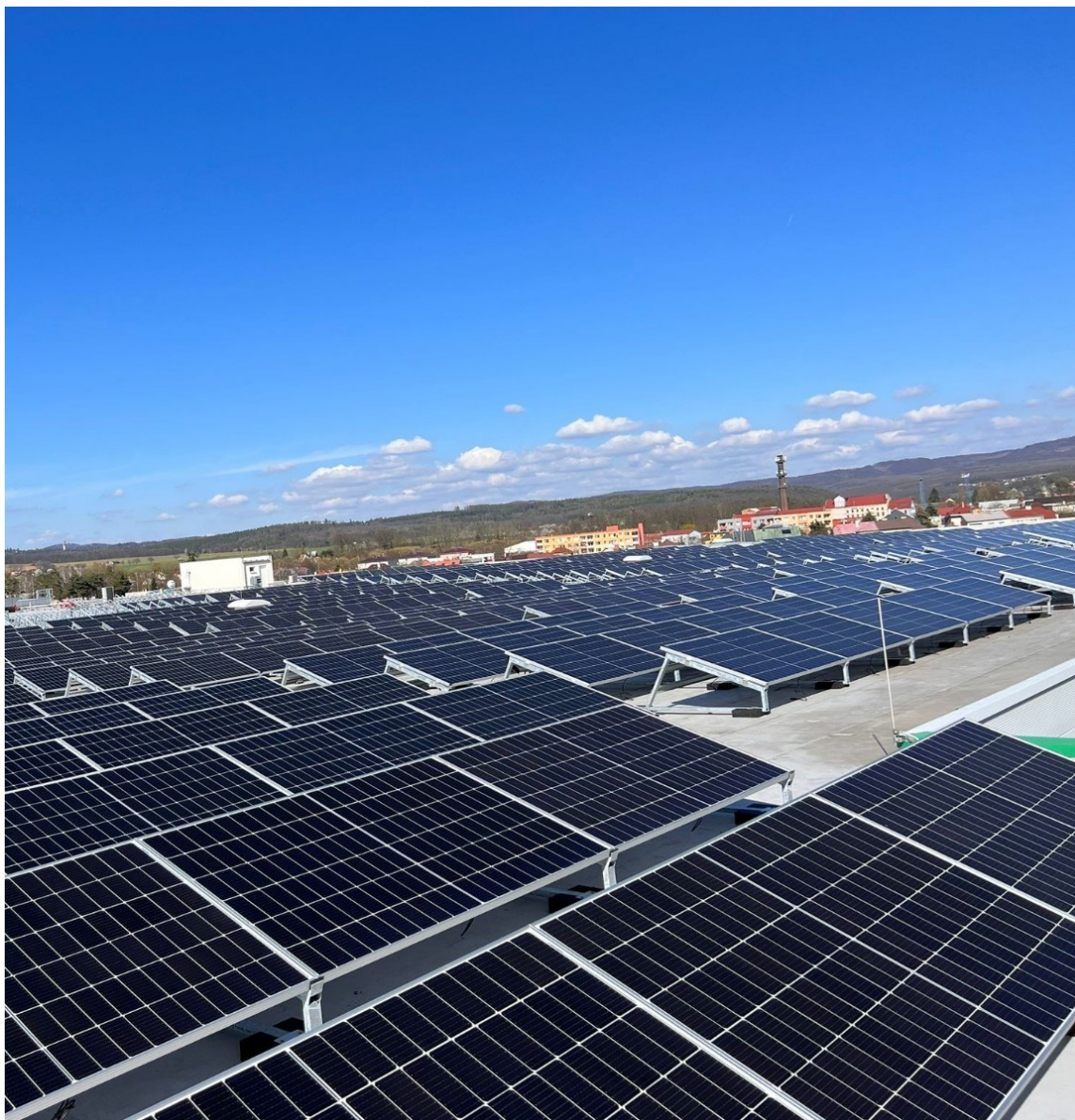
Obrázek 30 Instalace křemíkových panelů (Zdroj: vlastní)
