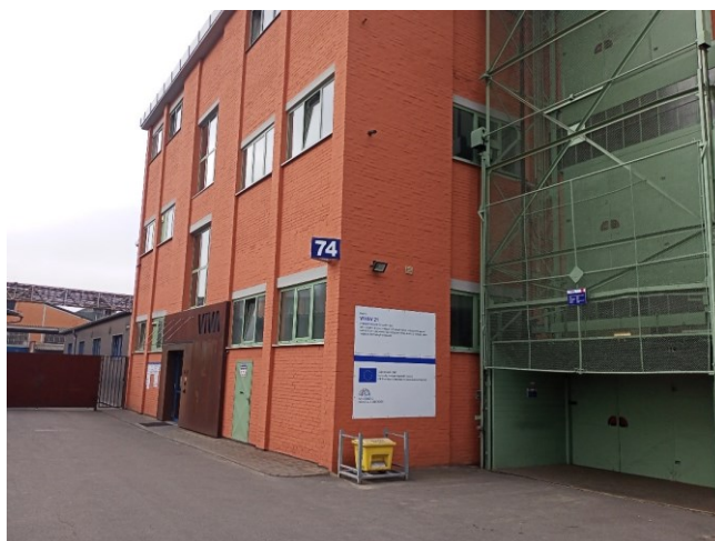
Obr. 37 - Budova CV Machining
