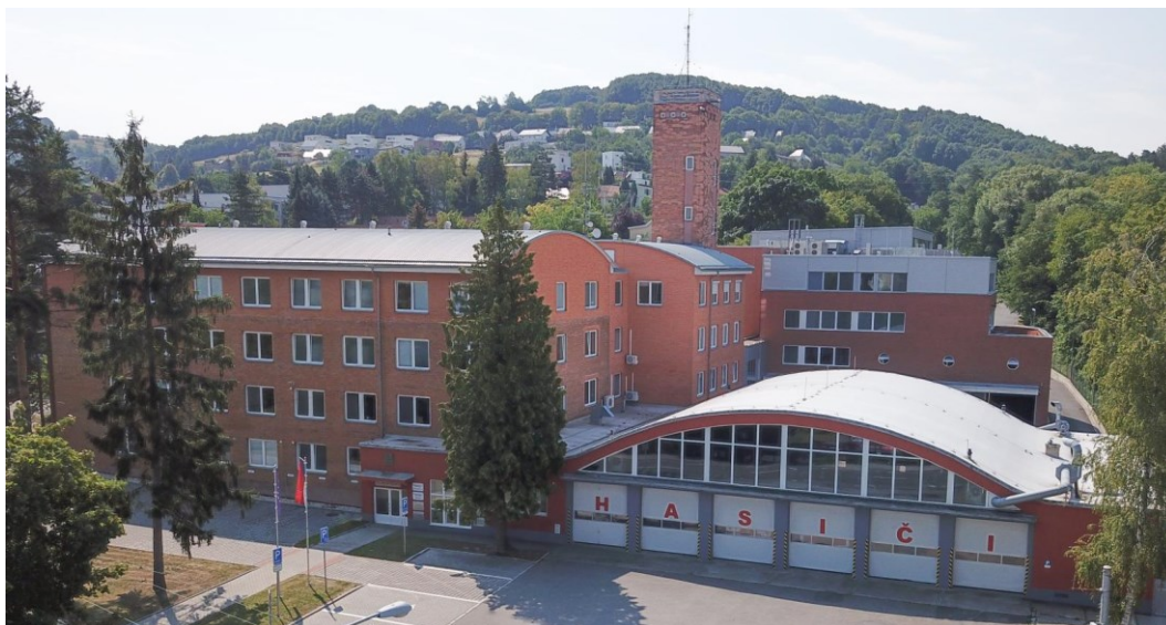
Obrázek 7 Požární stanice Zlín – kat. C3 (HZS ČR, ©2023)
