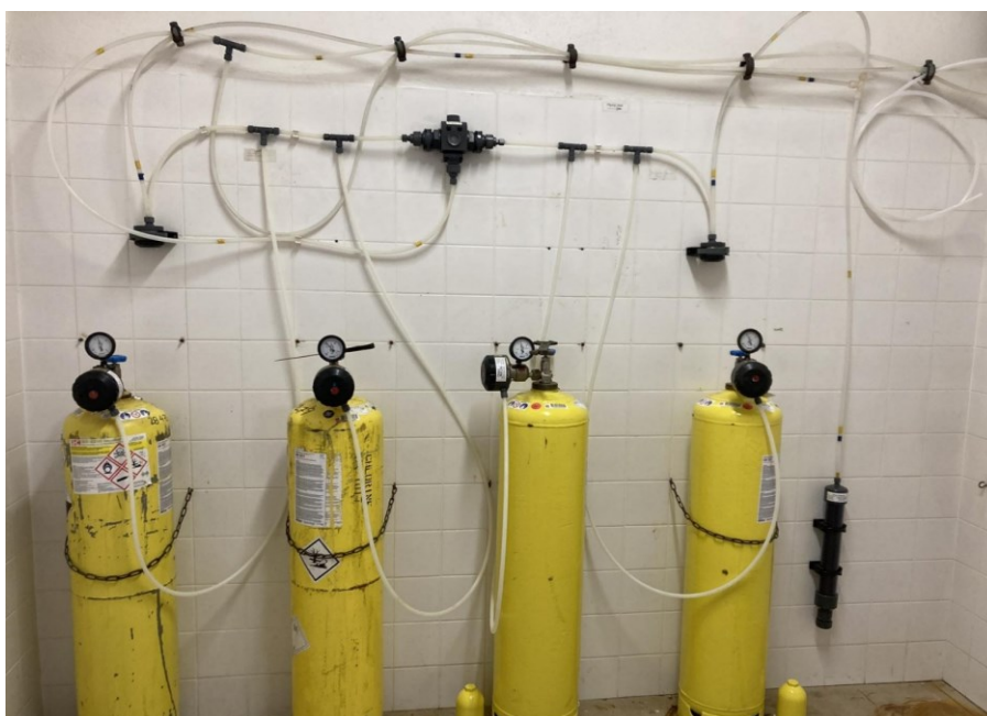
Obrázek 9 – Tlakové láhve v chlorovně v aquaparku Jihlavy. (vlastní)
