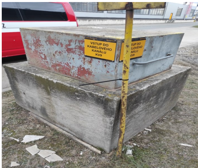
Obrázek 18: Vstup do KV9 (foto autor)
