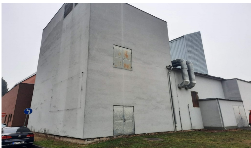
Obrázek 24 Strojovna chladicího zařízení zimního stadionu v Hodoníně (zdroj vlastní)
