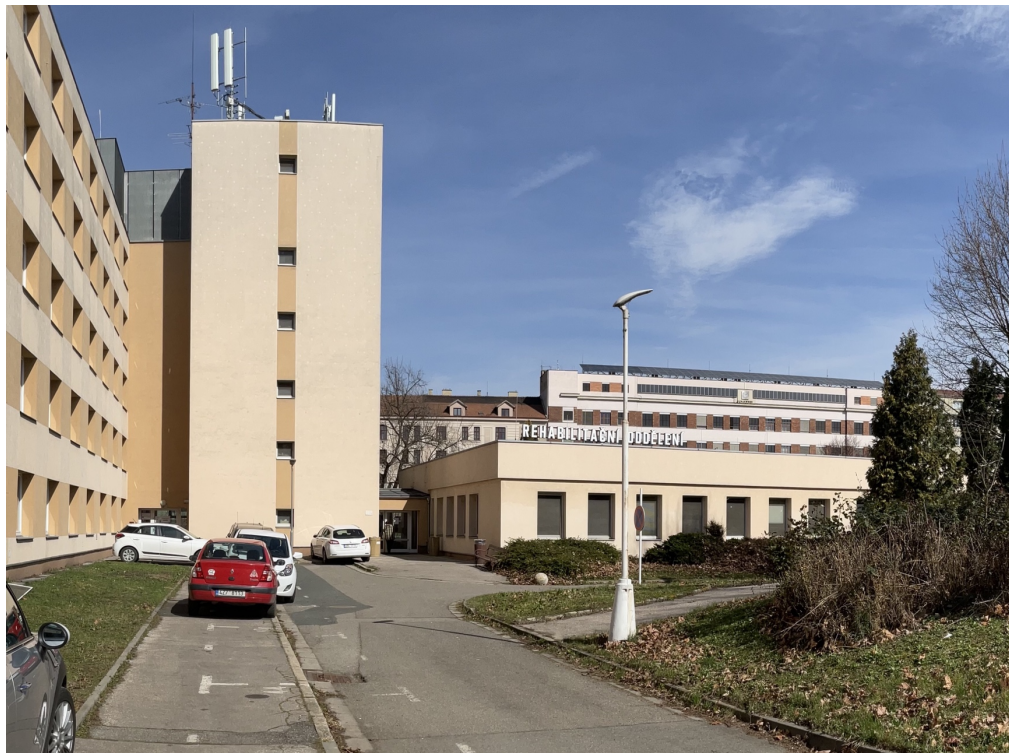
Obrázek 28 Značení oddělení Rehabilitace
