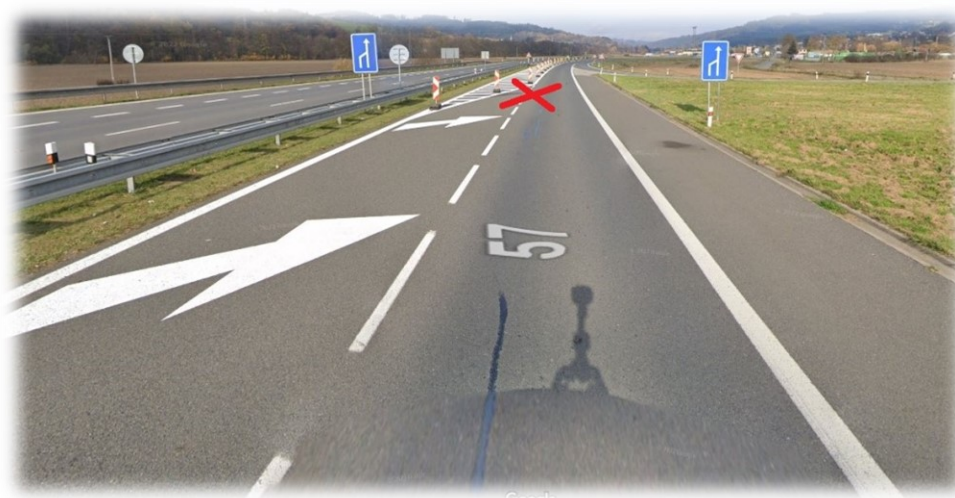
Obrázek 18 Silnice I/57 – čtyřpruh (Google Maps, upraveno)
