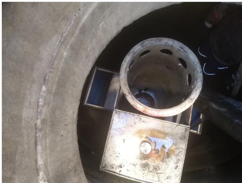
Obrázek 5 Odlučovač ropných látek.
