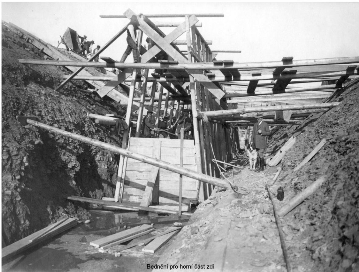
Obrázek 12 Bednění pro horní část zdi hráze
