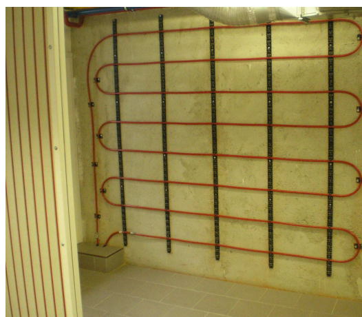
Obr. 24. Stěnové vytápění REHAU
