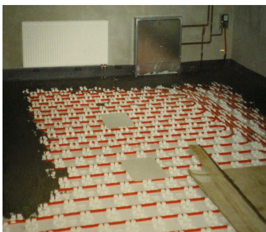
Obr. 26. Pokládka betonové mazaniny
