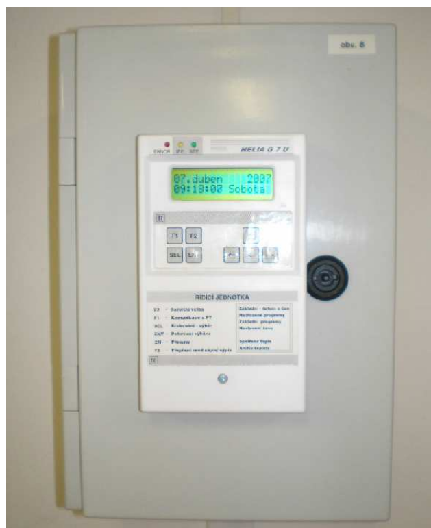
Obr. 18. Zařízení k odečítání teplot na jednotlivých čidlech
