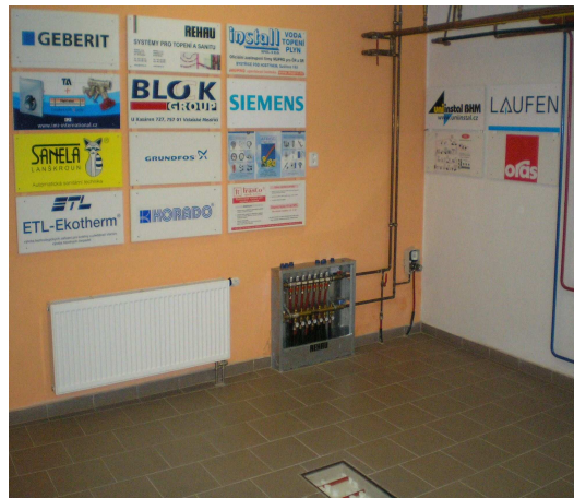
Obr. 22. Otopné těleso s rozdělovačem
