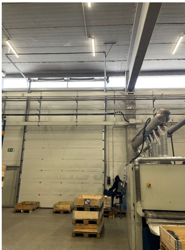
Obrázek 9 Sdružené osvětlení ve výrobní hale
