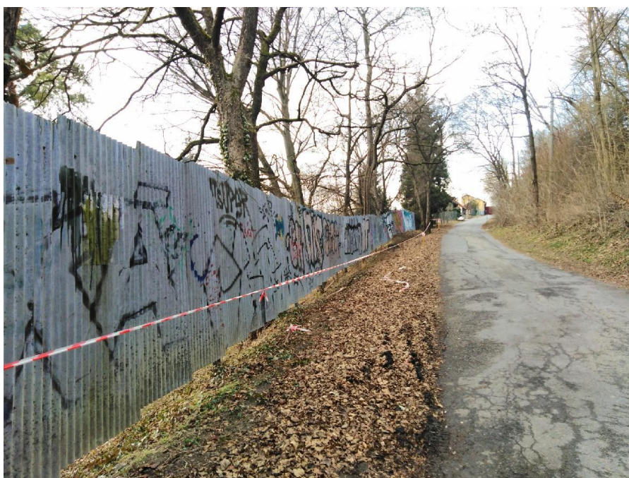
Obrázek 8 – Bezpečnostní opevnění části stadionu – plot (vlastní, 2022)
