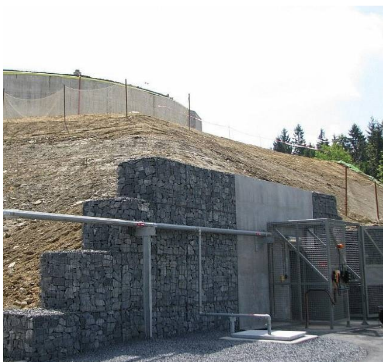
Obrázek 11 - Vstup do obslužné chodby (Čepro plní na maximum obří nádrže v Loukově, 2011)
