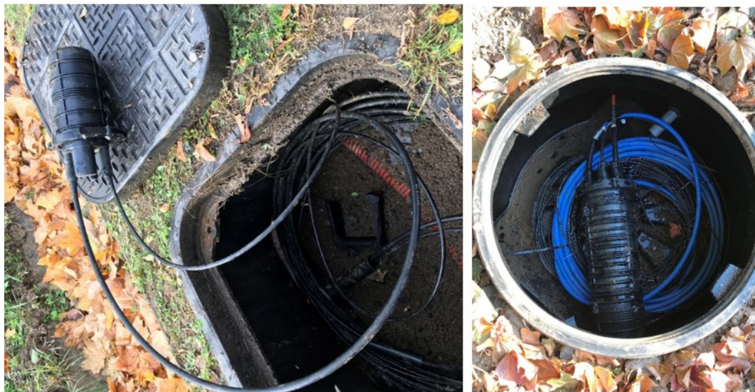
Obr. 14 Optické spojky v romoldu
