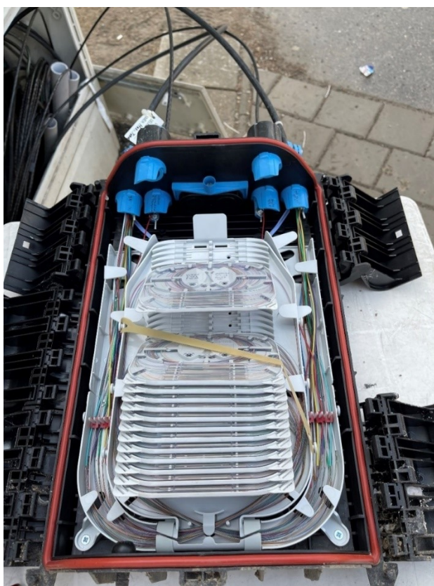
Obr. 25 Svařená optická vlákna v OS
