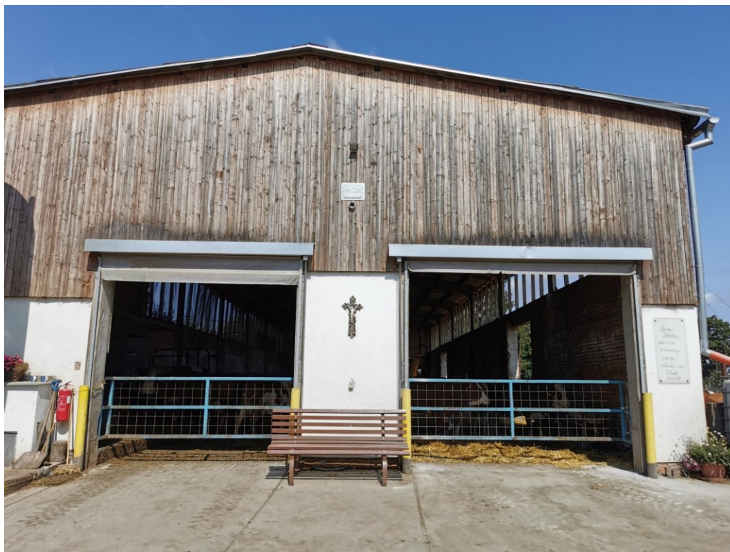
Obr. 3. Hlavní vchody do stáje pro dojnice, budovy č.1 (Zdroj: vlastní).
