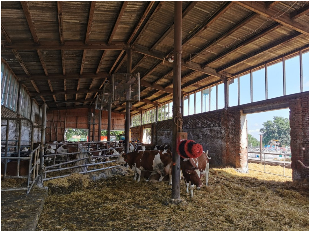
Obr. 1. Stáj pro dojnice, budova č. 1 (Zdroj: vlastní).
