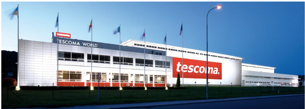
Obrázek 10 Logistické centrum Tescoma
