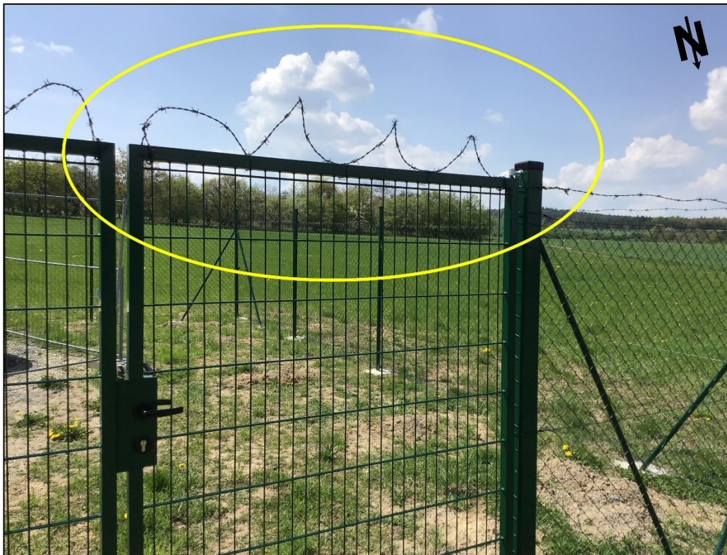
Obrázek 22 Vrt HV 3 – nevhodně zvolený systém vrcholových zábran [vlastní]
