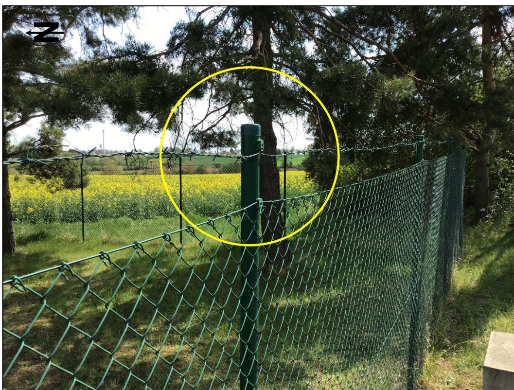
Obrázek 20 Vrty HV 1, 2 – vyháknutí vrcholové zábrany [vlastní]
