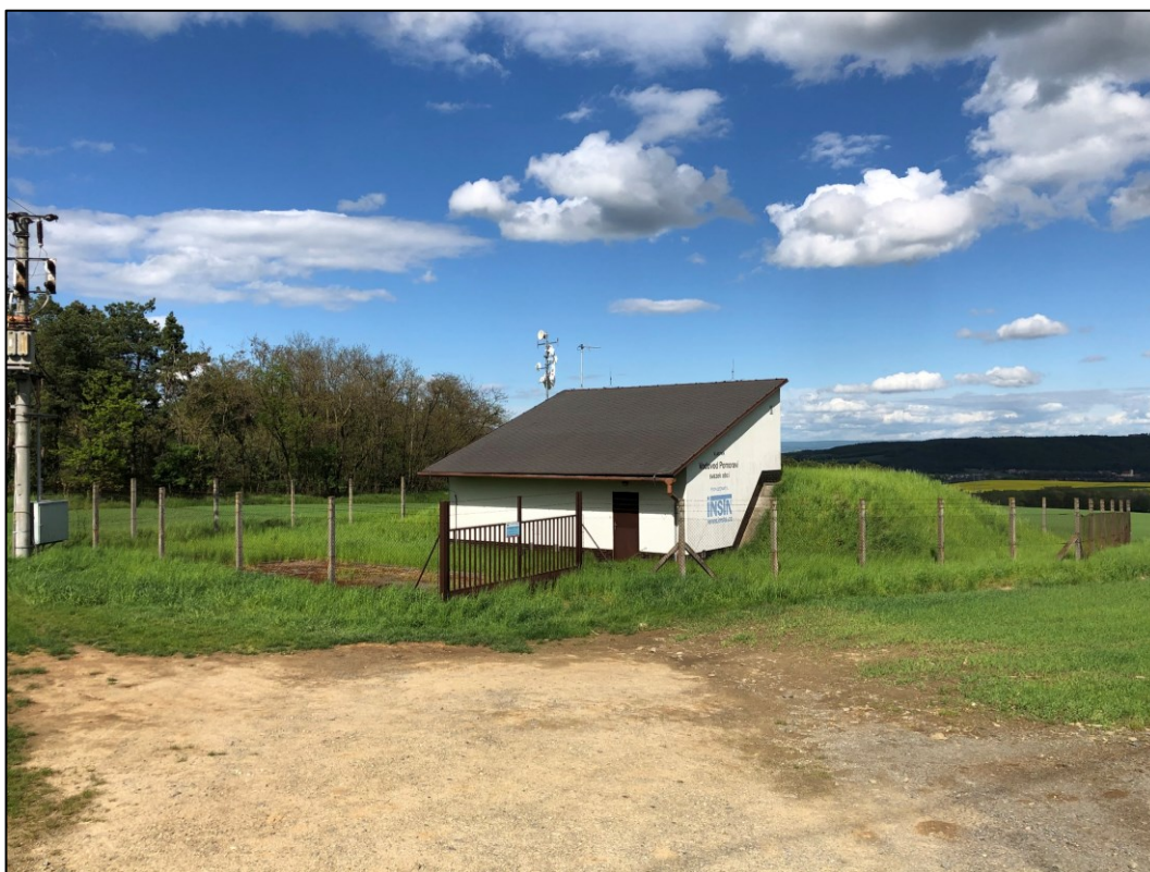
Obrázek 1 Zemní vodojem [vlastní]
