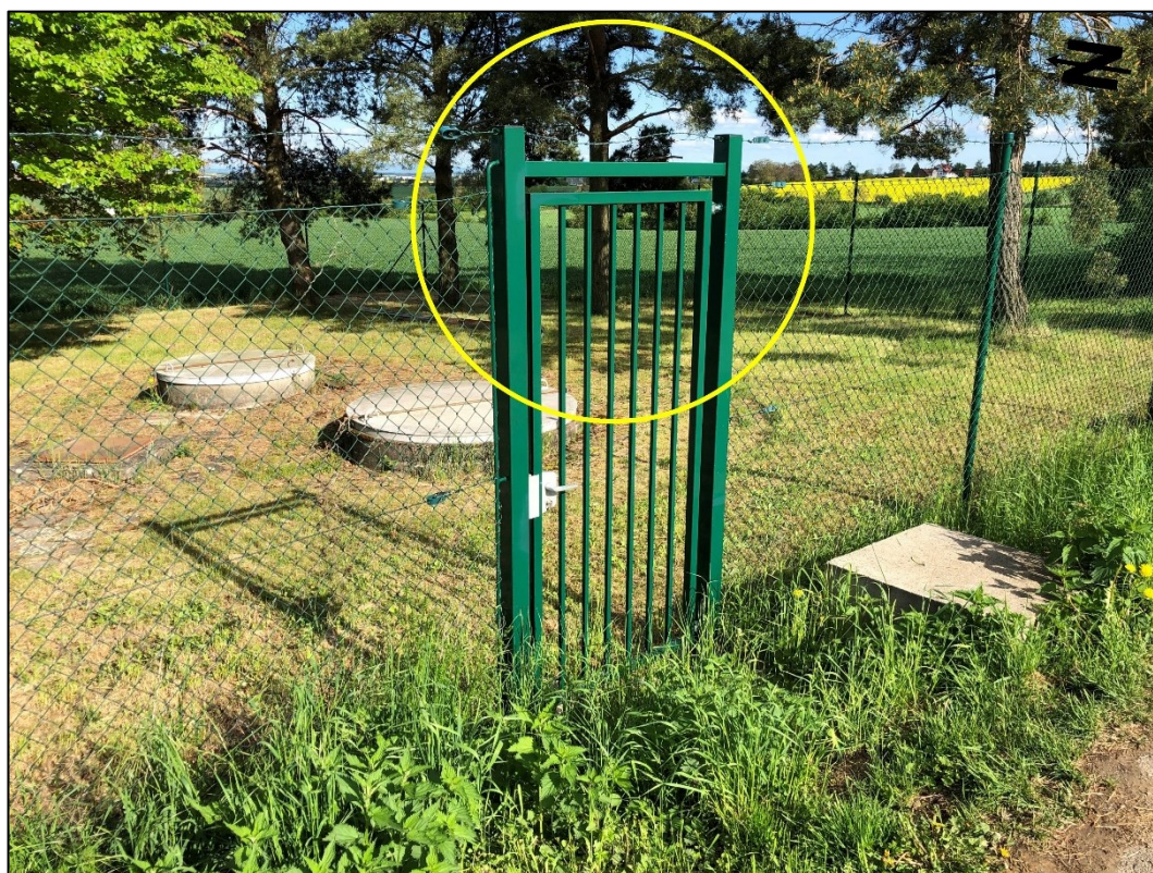
Obrázek 18 Vrty HV 1, 2 – nevhodně zvolený systém vrcholových zábran [vlastní]
