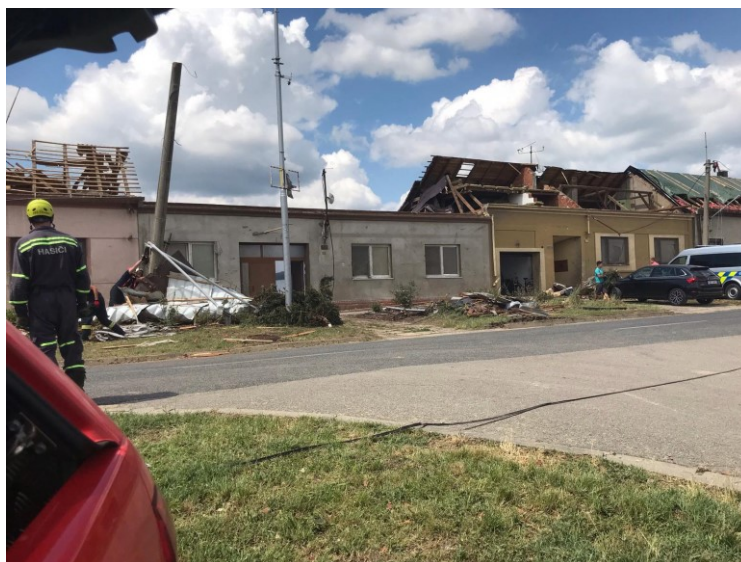
Obrázek 20. Stržená střecha (Zdroj: vlastní).
