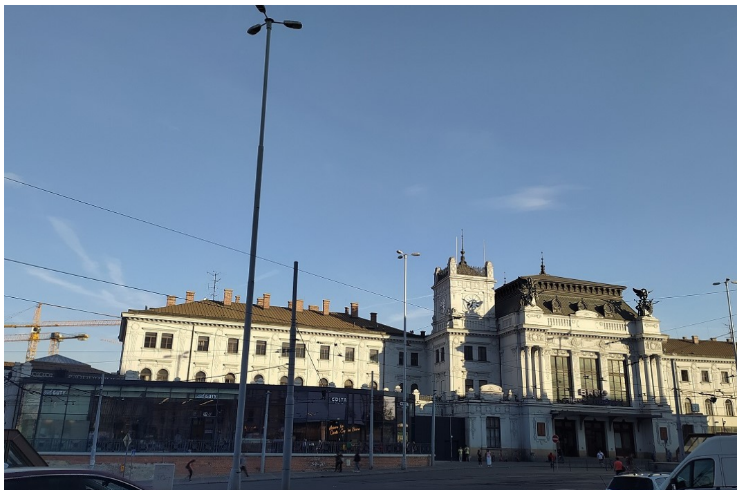
Obr. 26. Zrekonstruované levé křídlo hlavního nádraží [vlastní zdroj]
