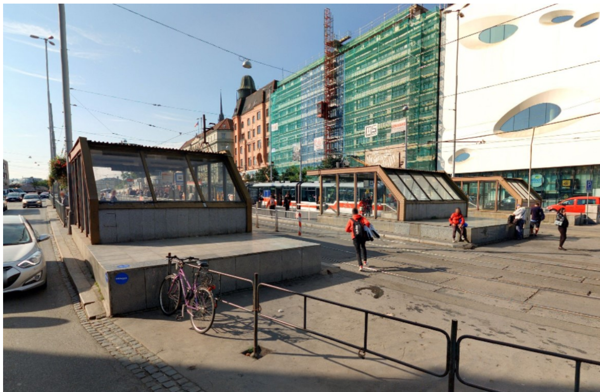
Obr. 42. Vstupy podchodů na hlavním nádraží [44]
