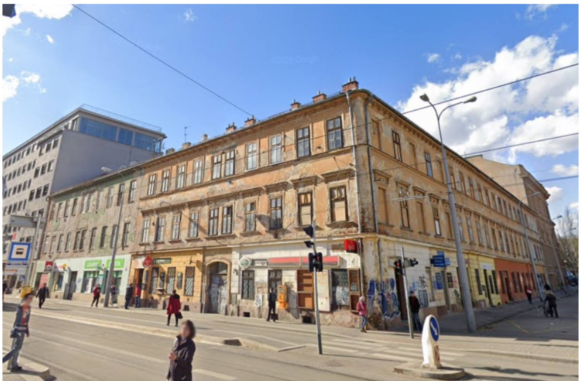
Obr. 60. Zastávka Náměstí 28. října na ulici Milady Horákové [44]
