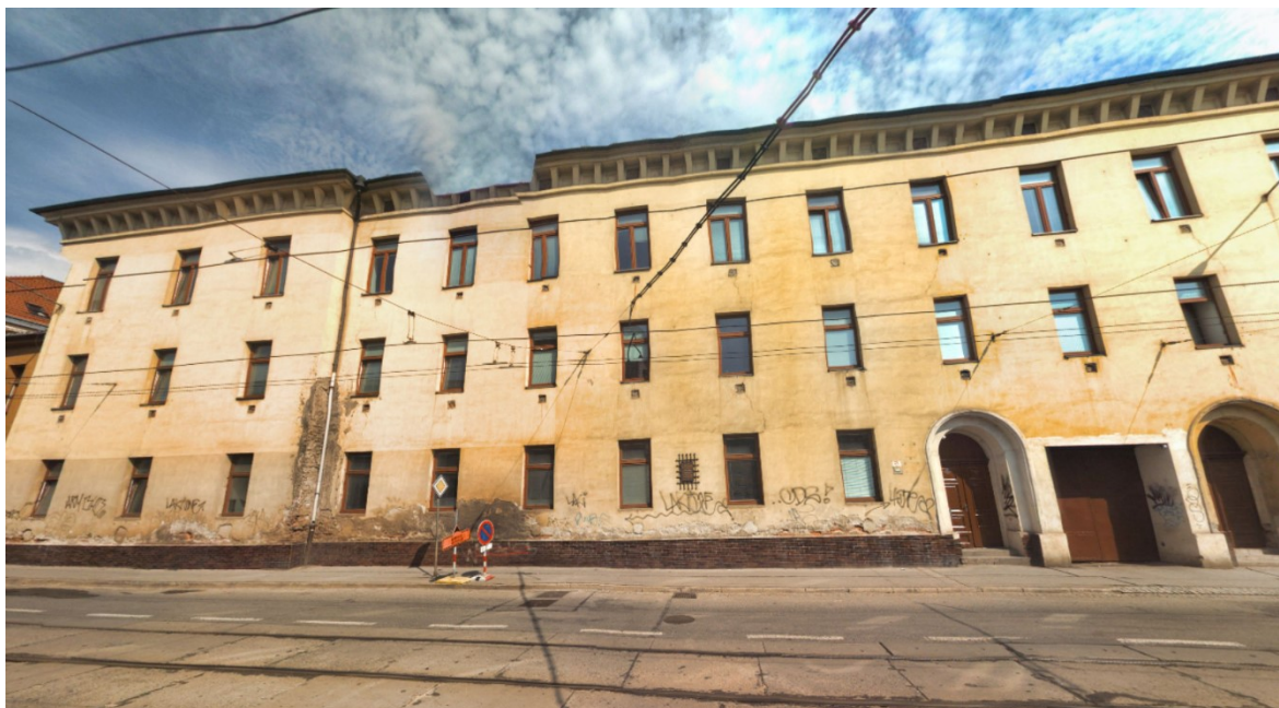
Obr. 20. Ubytovna na ulici Cejl [44]
