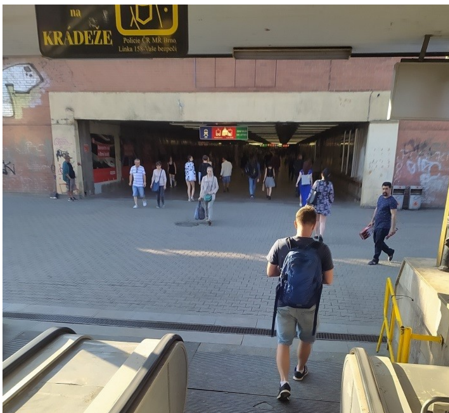
Obr. 55. Aktuální stav podchodu [vlastní zdroj]
