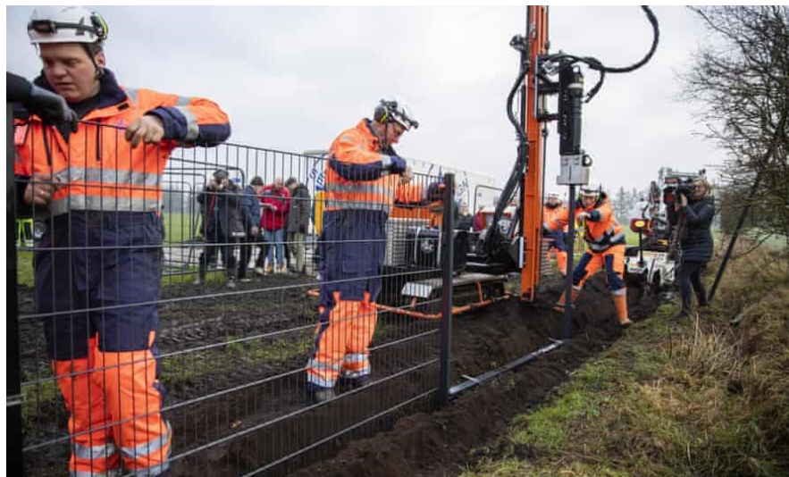
Obrázok 23 Konštrukcia plotu na dánsko nemeckej hranici [27]
