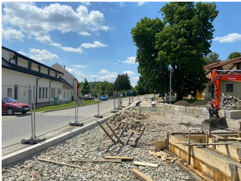
Obr. 17. Průběh stavebních prací v ulice Podhájí (Pište starostovi a, 3.6.2021)
