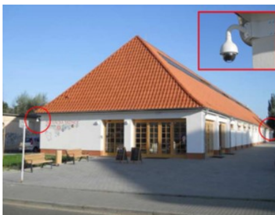
Obrázek 7 – Kamera na budově Slovácké tržnice – ulice Verbířská
