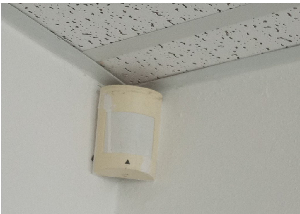
Obrázek 16 – Pohybové čidlo Paradox PIR 476 Plus [Zdroj: vlastní zpracování]
