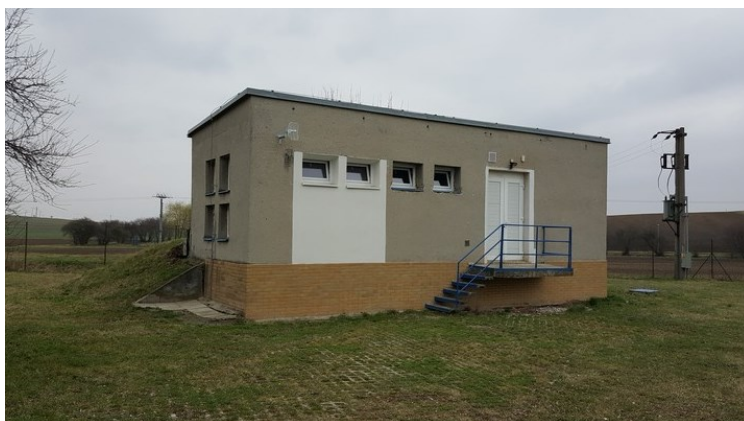
Obrázek 13 - Čerpací stanice Dobrochov (Skupinový vodovod Dobrochov, 2021)
