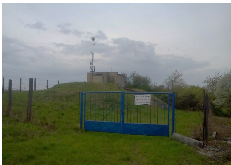
Obrázek 14 - Vodojem Otaslavice (Skupinový vodovod Dobrochov, 2021)
