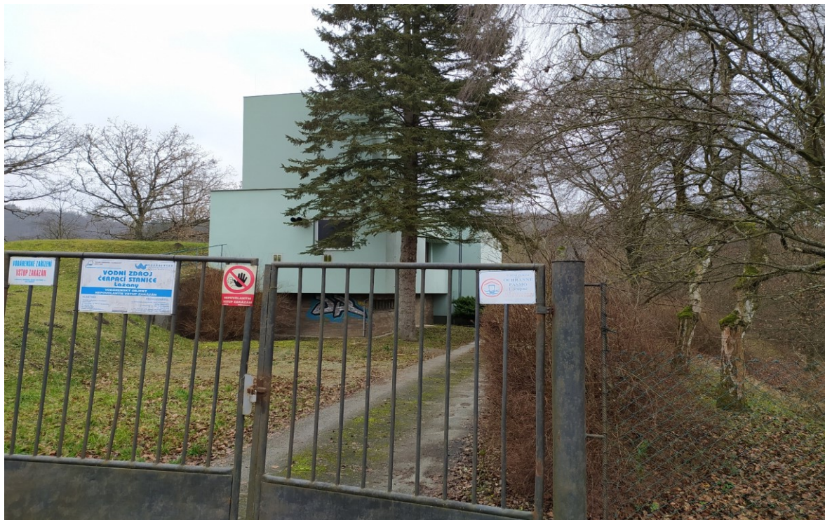
Obr. 22 Čerpací stanice Lažany
