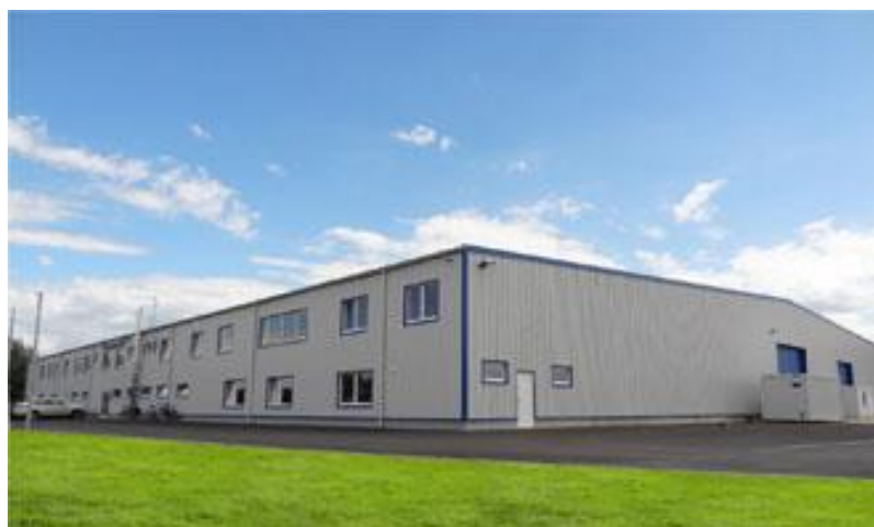
Obrázek 4 Budova společnosti Futures Contproduct s.r.o. (futures-contproduct.cz)
