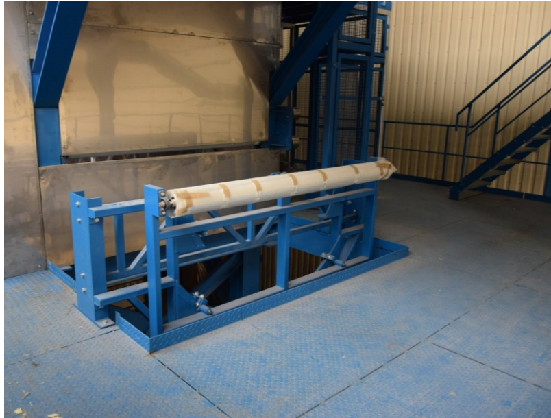
Obrázek 50. Instalace vyrovnávacího zařízení.
