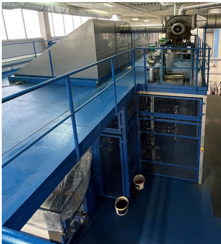
Obrázek 52. Střecha sušárny a odtah vzdušiny.
