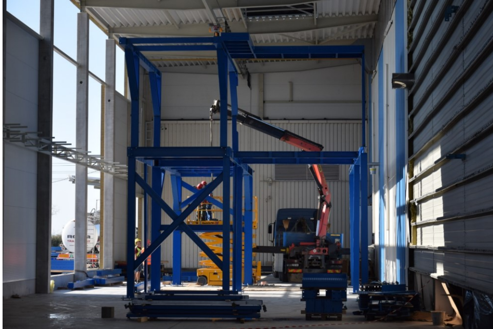
Obrázek 48. Realizace nosného rámu linky.
