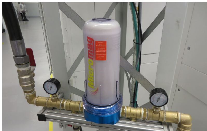
Obr. 54 Filtrační patrona v provozu [27]
