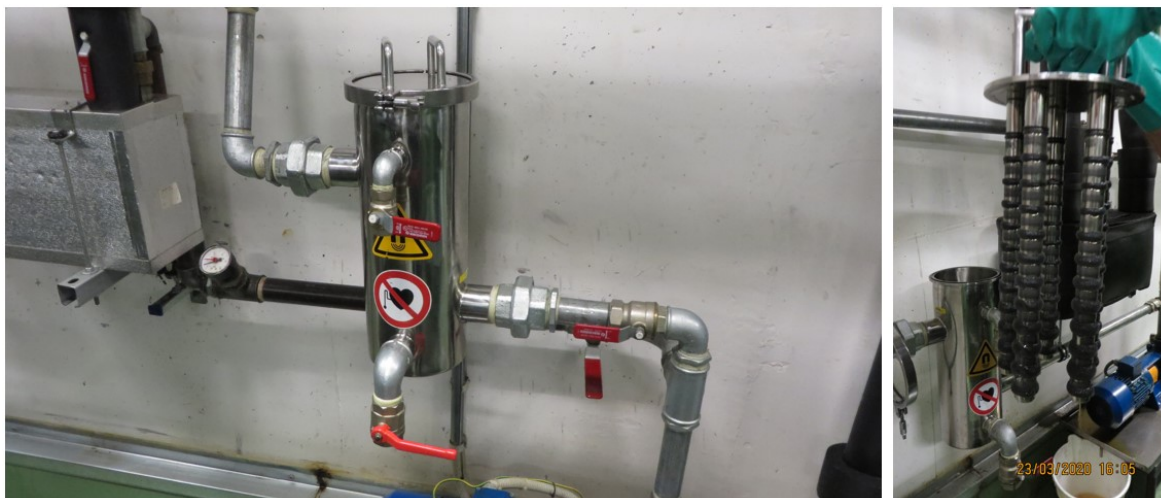
Obr. 25 Magnetický filtr pro dodatečnou filtraci [27]
