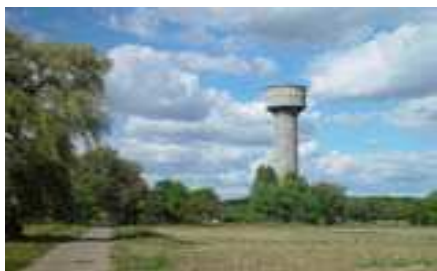
Obr. 2. Vodárenská věž v Břestě
