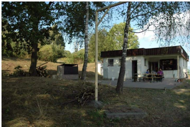
Obr. 5 původní stav areálu Malá skála (Zdroj: archiv spolku)
